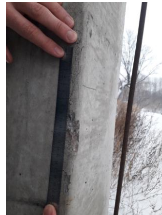
Рис. 2.1. Внешний вид и методика измерения железобетонной опоры
