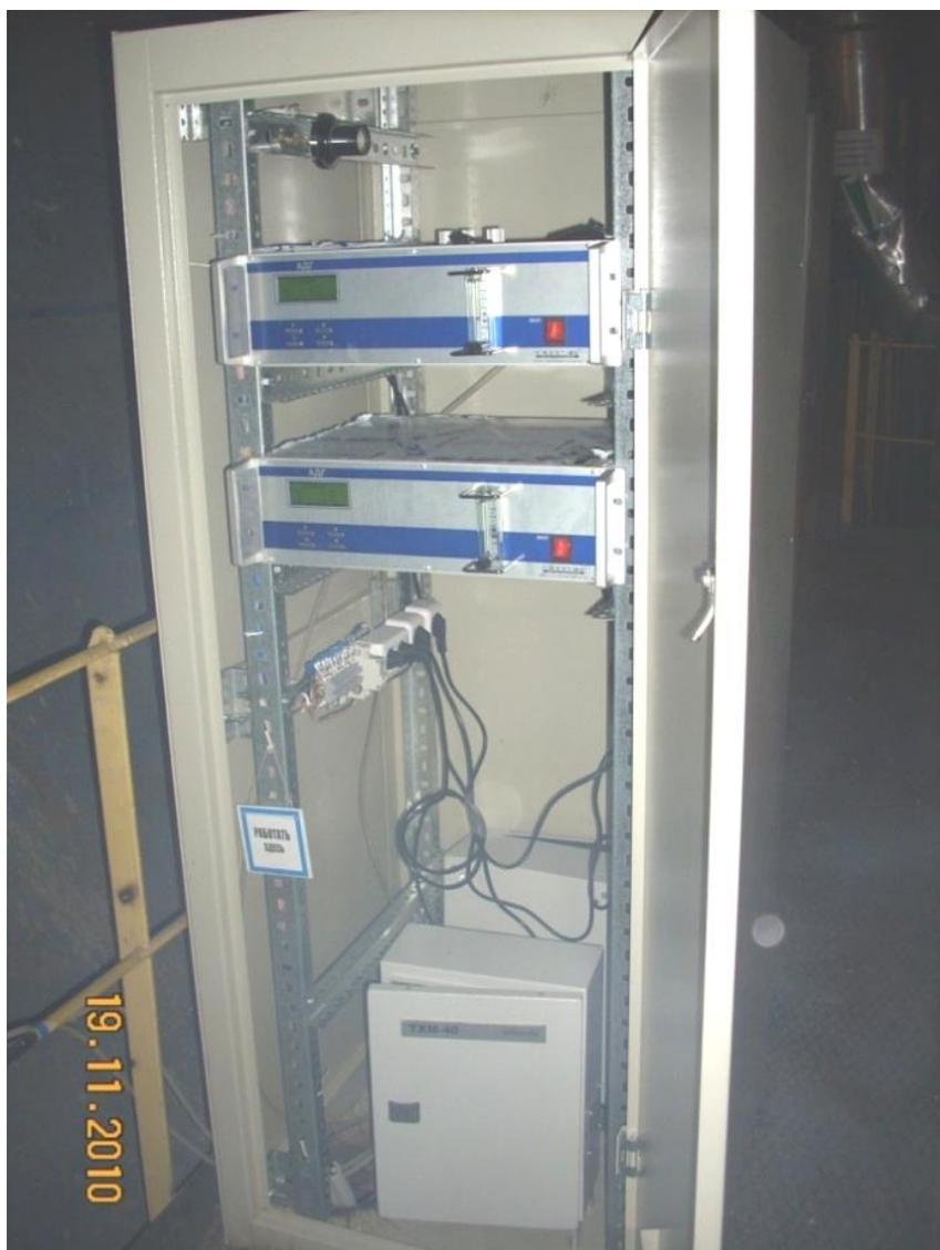
Рис. 4.10. Два газоанализатора АДГ-304 с устройствами пробоподготовки в монтажном шкафу
